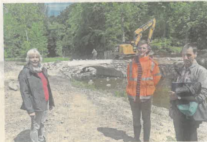
Baubesprechung am Osterkampsredder: Guido Schiering (Landesamt für Küsten- und Naturschutz), Ingenieur Johannes de Wall und Carolin Welchert aus dem Bauamt der Stadt Bad Schwartau.
